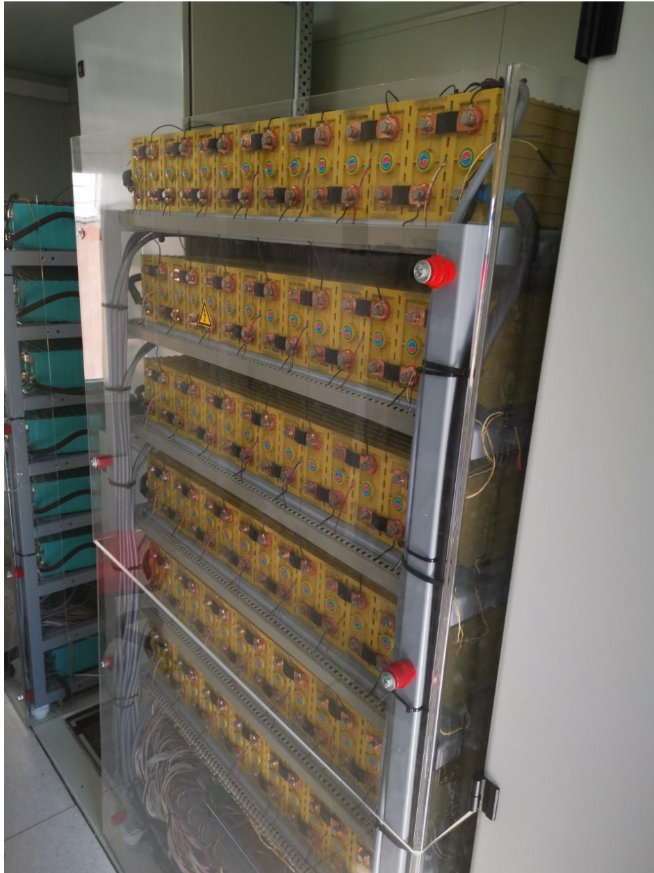
Sl. 1.3 Drugi niz litij-ionskih baterija kapaciteta 100 Ah s pripadajućim BMS sustavom ispod baterija
