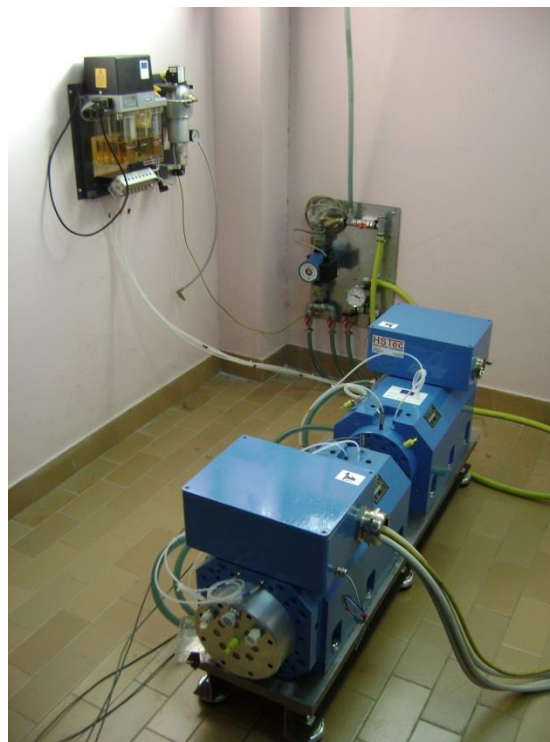
Slika 8. Visokobrzinska motor-generator grupa s uljnim agregatom i rashladnim sustavom.
